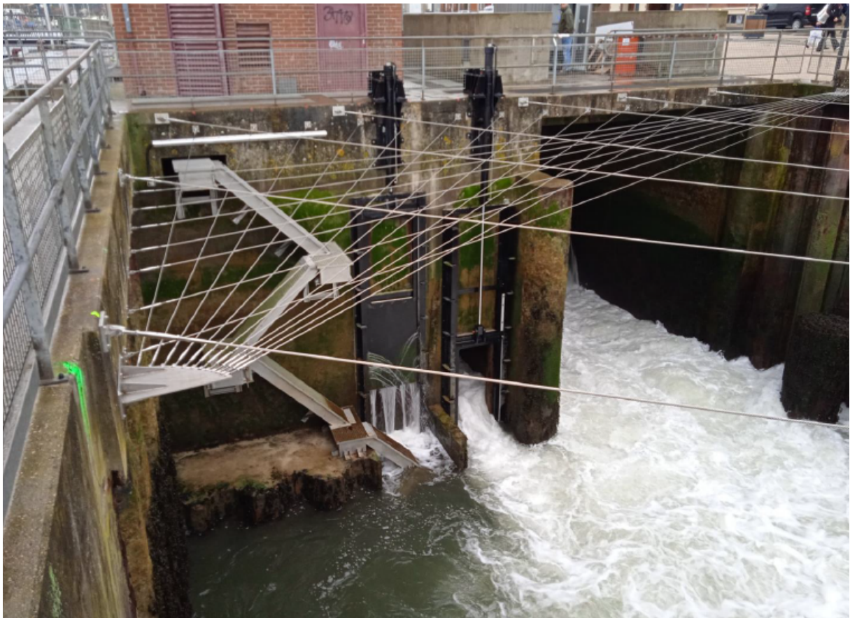
Figure VI.2. Vue aval de la passe-à-poissons du Tréport et des câbles anti-bracconnage.
