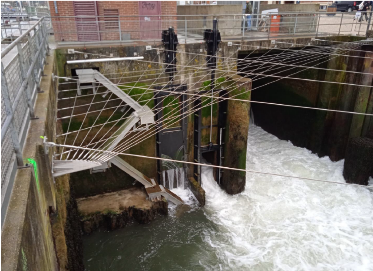
Figure VI.2. Vue aval de la passe-à-poissons du Tréport et des câbles anti-braconnage.
