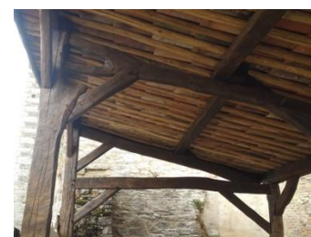
Fig. 3 : charpente en bois équarri @Photo P. Warengo
