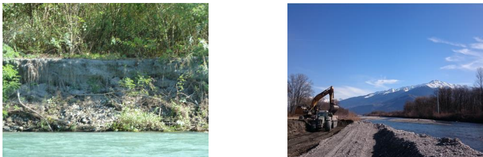
Figure 1: Végétalisation de banc et dépôt massifs de sédiments fins sur les bancs de l'Isère (gauche) et travaux de restauration (droite)
