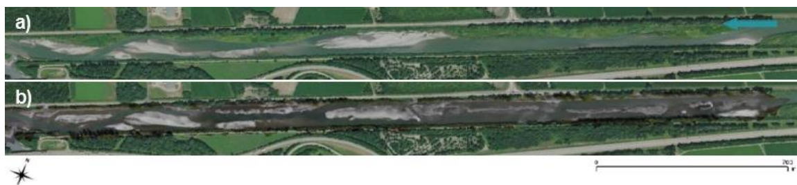
Figure 4 : Localisation du site d'étude (Isère en Combe de Savoie) et exemple de travaux (essartement, arasement et remodelage des bancs) réalisés sur le secteur de Fréterive sur l'Isère en Combe de Savoie. a) Lit avant travaux en 2016, b) lit après travaux en 2017.
