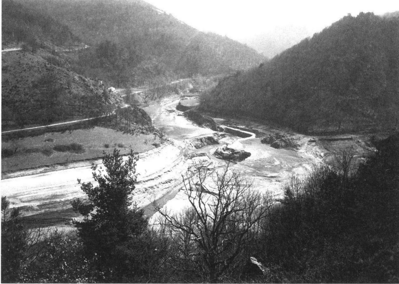
Figure 9 : Exemple de chenal créé dans les sédiments par un abaissement du plan d'eau : L'Ondaine dans la retenue de Grangent
