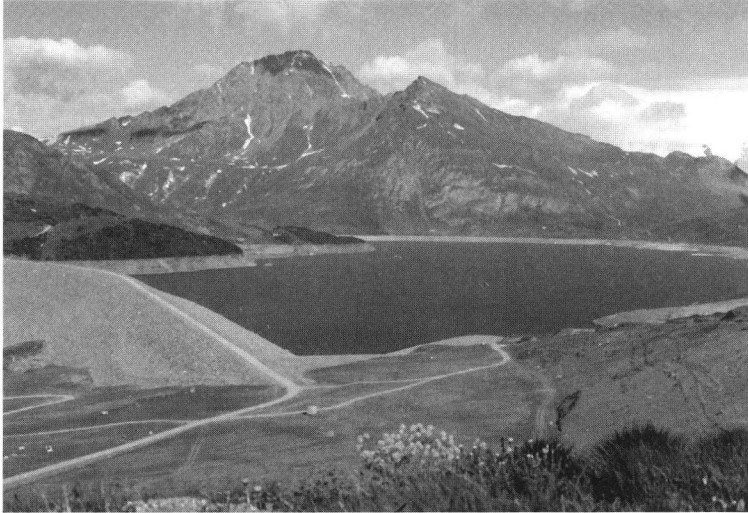
Photo 2 : Barrage et lac du Mont Cenis.
