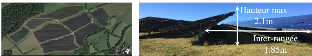
Figure 2 : Photographie satellite du site de Marmanhac (gauche) et de l'infrastructure des panneaux (droite).
