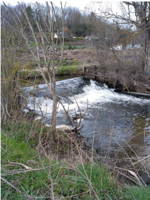
Annexe 8 : Photographie du ROE57525 – Seuil de l'ancienne STEP
