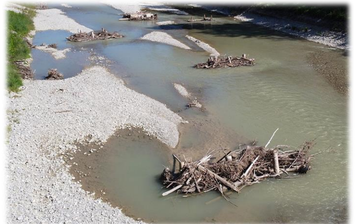
Réintroduction de bois fixé par des pieux sur l'Emme (Suisse) © M. Mende tiré de Neuhaus & Mende (2021). Water 2021, 13(18)2520 https://doi.org/10.3390/w13182520
