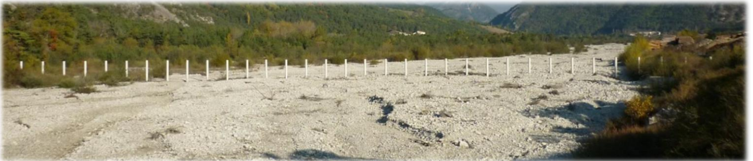
Râtelier à flottants situés sur la Béoux, affluent du Petit Buëch (Hautes-Alpes)
