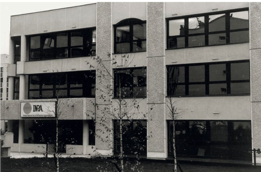
Années 1990, façade du bâtiment de l'Inra à Ivry-sur-Seine, entièrement occupé par des unités de recherche et des services du département d'Economie et de sociologie rurales.
