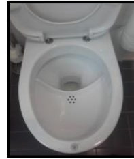
Toilettes à séparation (Roediger)
