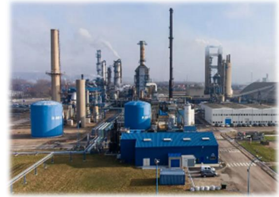
Usine de production d'engrais azotés au Havre (Les Echos)
