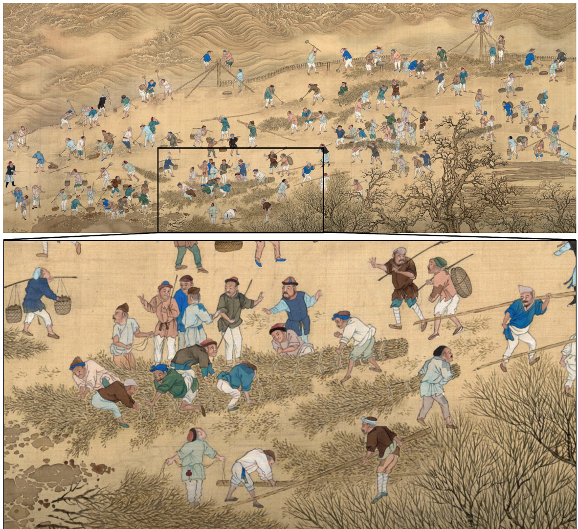
Figure 1 – Confection historique de fagots pour les fascines en Chine, rouleau de soie issu du Voyage d'inspection dans le Sud de l'empereur Kangxi XVII e siècle © RMN-Grand Palais (MNAAG, Paris) / Michel Urtado.
