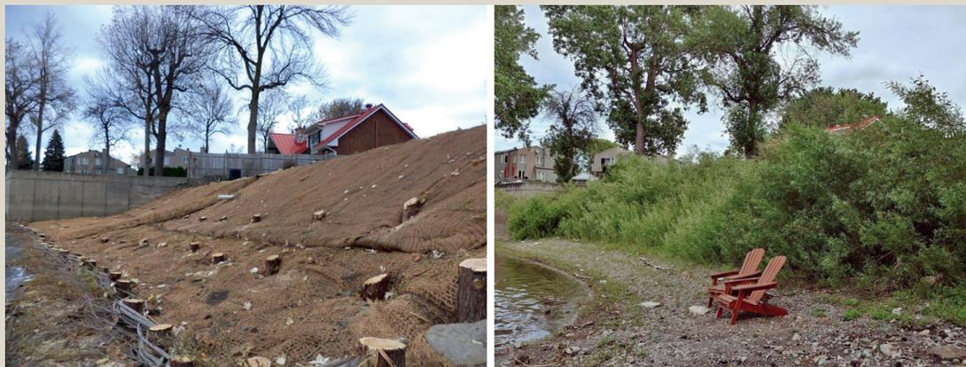
**Photo ④ –** Ouvrage de génie végétal mixte juste après sa réalisation et à la troisième saison de végétation sur la rivière Bow à Calgary. Crédit photographique : Terra Erosion Control.
