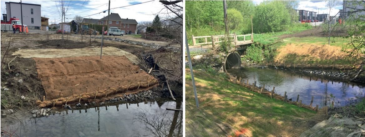
Photo 2 – Photo d'un ouvrage sur le ruisseau Sainte-Barbe à Québec, à la réalisation et à la reprise de la végétation. Crédit photographique : Hydro-Québec.
