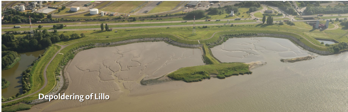
Figure 6 : Recul de la digue sur le site de Lillo sur l'estuaire de l'Escaut en Belgique
