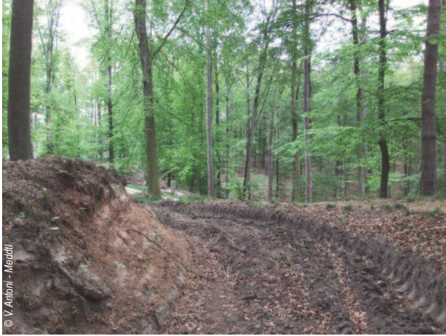
Tassement d'un chemin forestier dans les Vosges gréseuses (Bas-Rhin)
