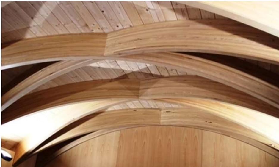
**Photo 2 :** Charpente en mix hêtre (structure) – épicéa (parement) de la structure d'accueil des habitations de loisir, à Xertigny (Photo de Q. Remy)
