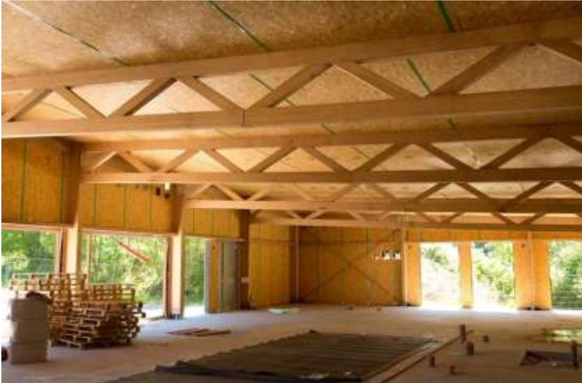
**Photo 4 :** Structure en lamellé collé de hêtre de l'atelier bois, lors de la construction (Photo de J.F. Hamard)
