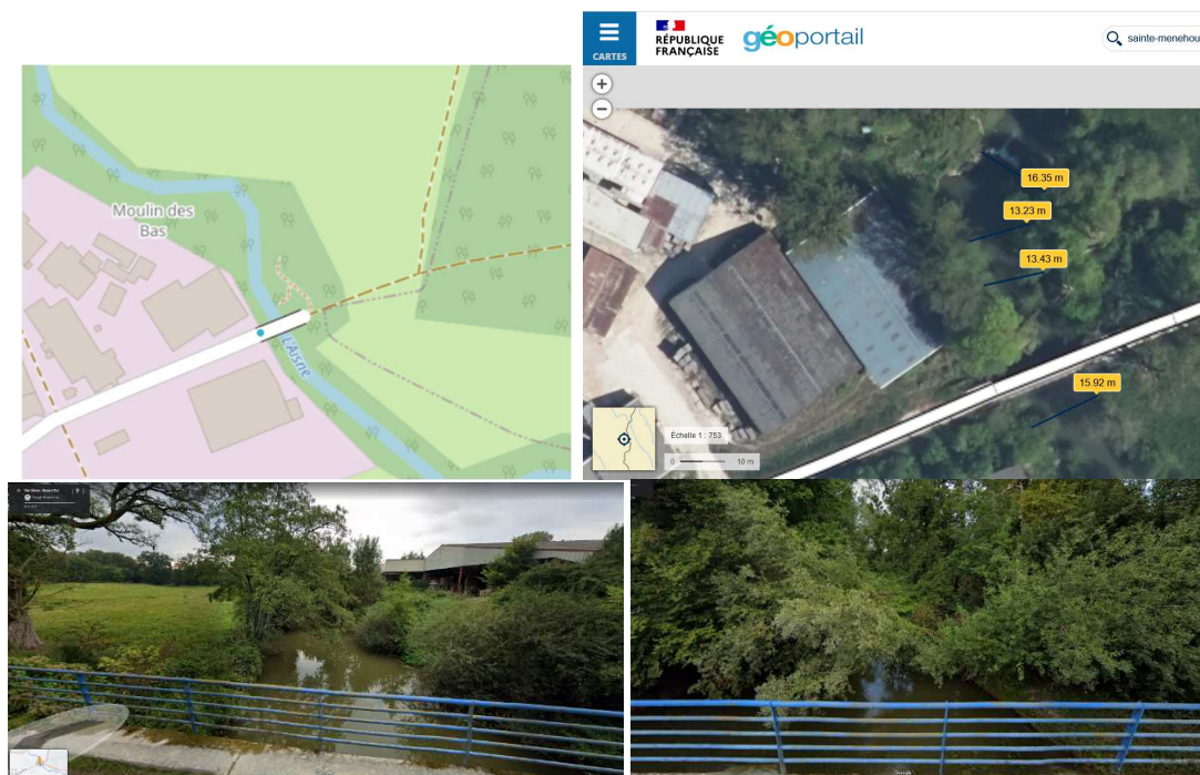
Fig. 31 – L'Aisne à Verrières (H6021020) : situation de la station et vues des contrôles en amont/aval
