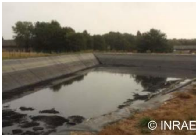
Lagune de stockage de digestat liquide
