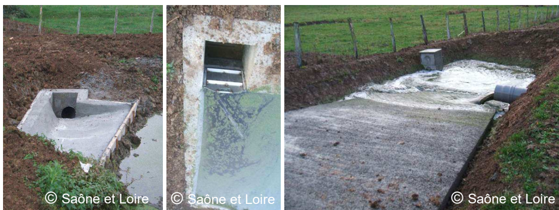
Figure 8 : Seuil déversoir aménagé (gauche), pelle murale opérationnelle (centre), zone de récupération des lentilles (droite)
