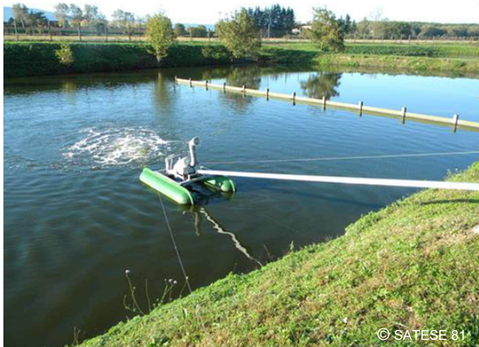
Figure 34 : Ajout d'aérateur de surface à vis hélicoïdale sur une lagune 1
