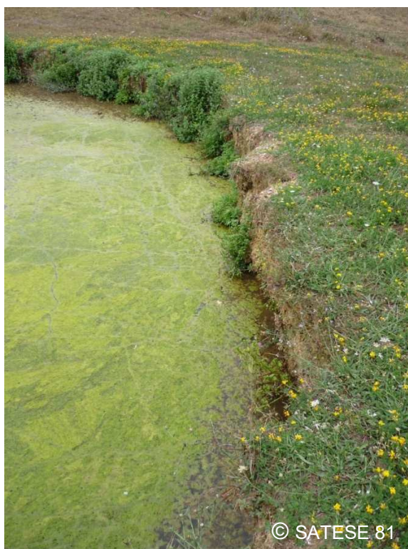
Figure 13 : Berges dégradées et lentilles d'eau
