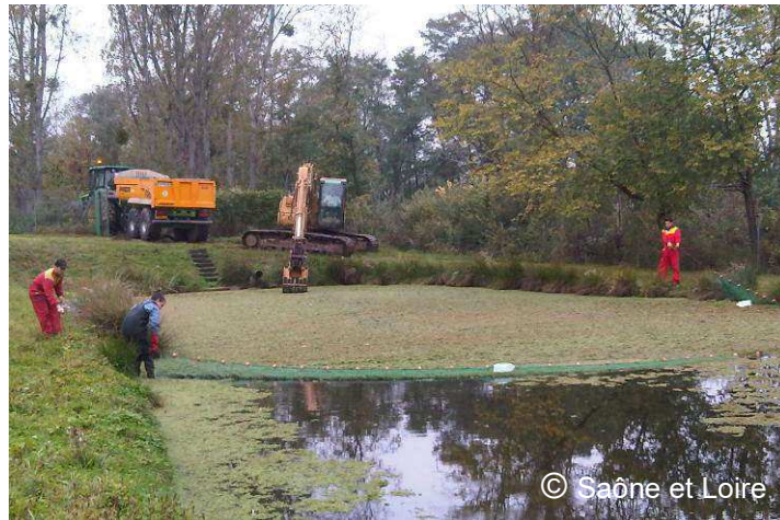
Figure 10 : Raclage de surface et récupération des lentilles au godet étanche
