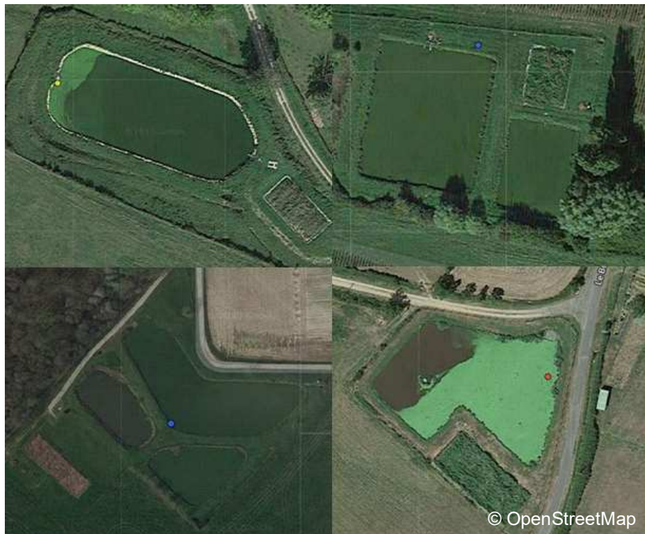
Figure 28 : Exemple de lagunes réhabilitées avec un FPR en aval des lagunes
