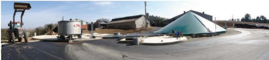
L'unité de méthanisation construite par Evalor avec un partenariat allemand Biogas Hochreiter
