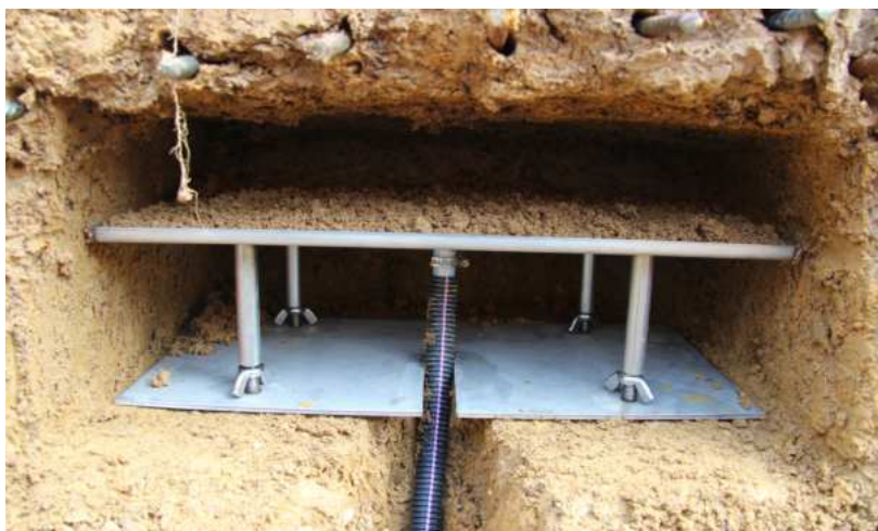
Lysimètres à mèche en cours d'installation. La plaque est ensuite mise en contact avec le sol
