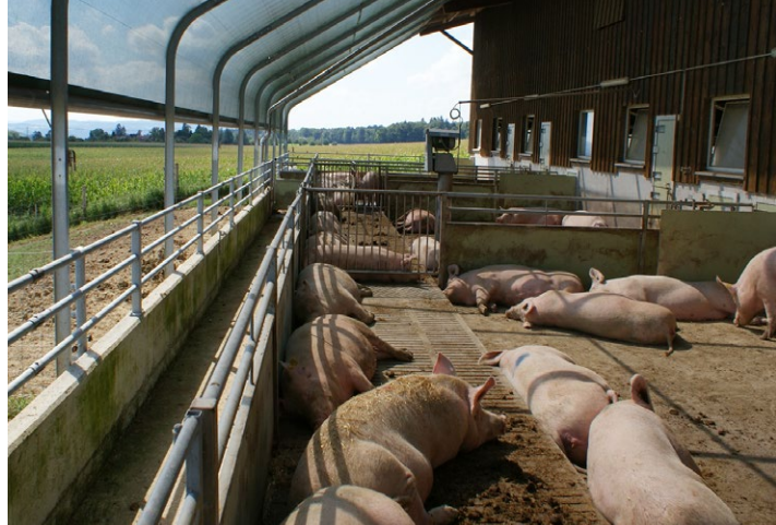
Les systèmes mixtes permettent d'accéder aux pâturages en plus de la courette en béton.
