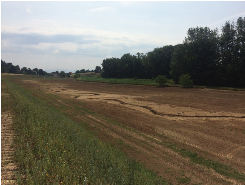
Figure 1. La zone d'expansion de crue à Vendenheim avec le cours d'eau reméandré (Drapier, 2023).
