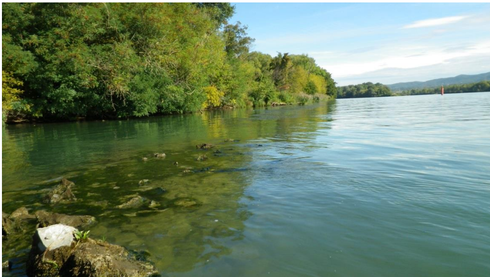
Photo 7 : Digue longitudinale d'un casier Girardon parallèle à la berge sur la station amont. © Mosaïque Environnement
