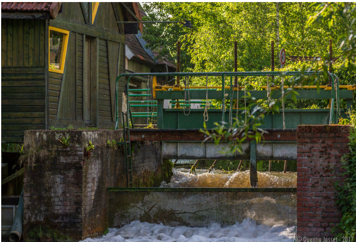
Figure III.4. Vue aval du piège du Lieu-Dieu (Beauchamps - 80) en fonctionnement.
