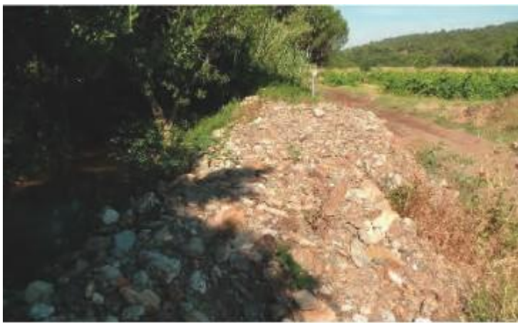
Figure 16 : Photo d'un merlon illégal sur le bassin versant du Gapeau.
