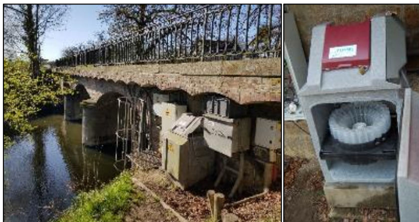
Figure 2 Gauche : station INRAE du Pont de Signy (aval) ; droite : préleveur automatique ISCO 5800 à cette même station.
