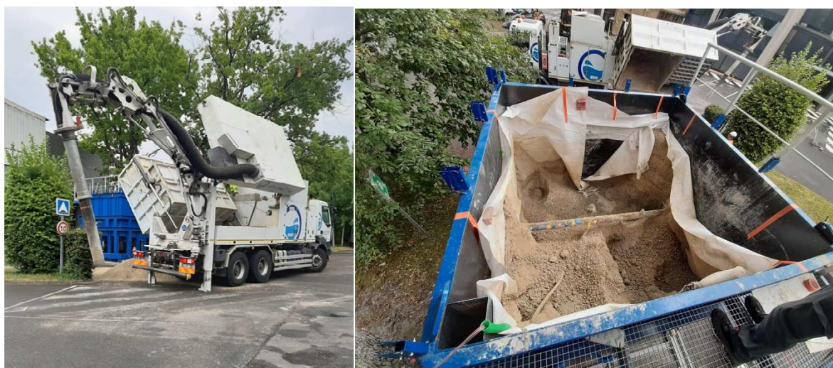
FIGURE 11 : VIDANGE DU CAISSON PAR ASPIRATION
