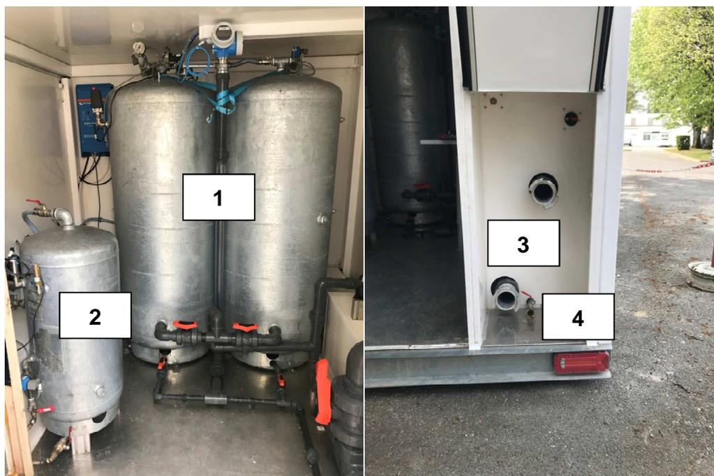
FIGURE 33 : CUVES (1), SYSTEME DE REGULATION DE PRESSION (2), ENTREE ET SORTIE (3) ET PURGE (4) DU CIRCUIT D'EAU
