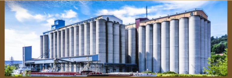
Silos de Frouard, Belleville et Delattre
