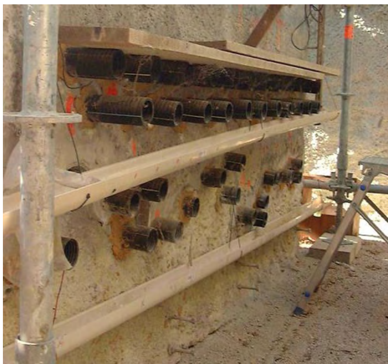
Figure 4. Photographie des drains avant l'installation des débitmètres (photo : EMMAH).
