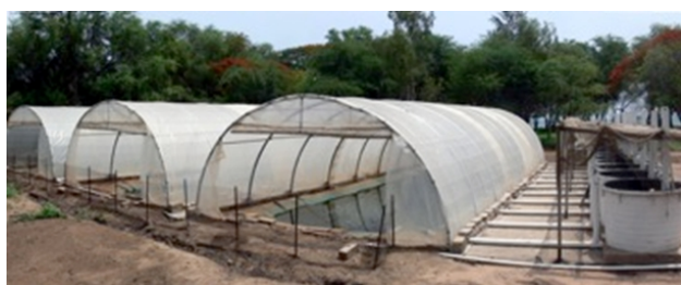
Figure 2. Schéma et photographie du prototype installé sur le centre IRD de Mbour au Sénégal : 1 et 2 bassins de lagunage, 3 bassin dédié à croissance du zooplancton, 4 bacs de grossissement, 5 bacs d'alevinage, 6 écoulement entre les bassins 1 et 2, 7 pompes fonctionnant en alternance, 8 et 9 filtres (© N. De Wilde).
