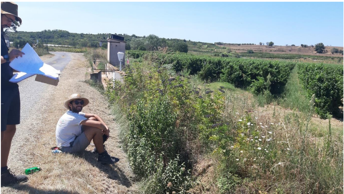
Fossé de l'exutoire (S01)
