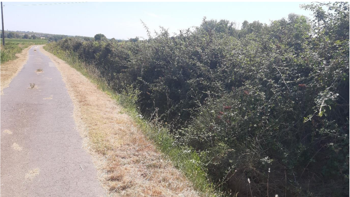
Fossé Coste Nord (S13)
