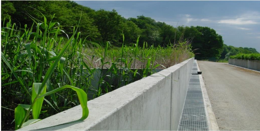
Photo : Filtres plantés de roseaux
