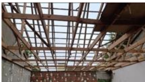
Fig. 4: Chantier de Floirac
