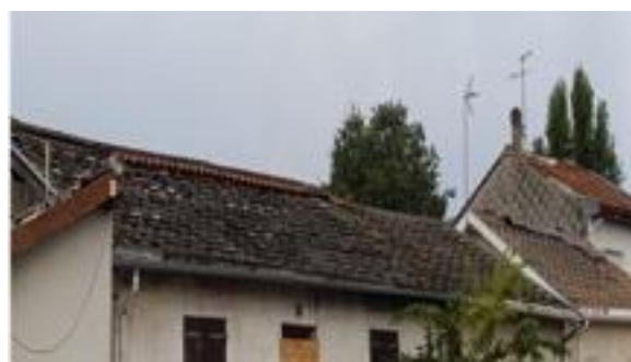
Fig. 5: Vue général de la charpente bois à Begles
