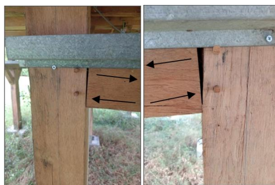
Fig. 13 : Rotation de la zone d'assemblage sous l'effet de la flexion
