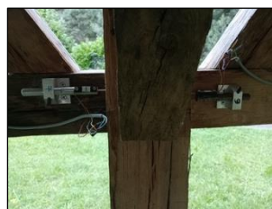
Fig. 4 : Capteurs 06 et 07 de mesures des déplacements relatifs entre poteau et poutres de la travée extérieure
