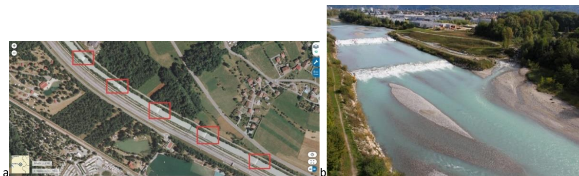
Figure 95 : a) exemple d'implantation de rampes sur l'Arve en amont de Sallanches et b) rivière de contournement piscicole de deux rampes à Pressy (commune de Thyez) © SM3A
