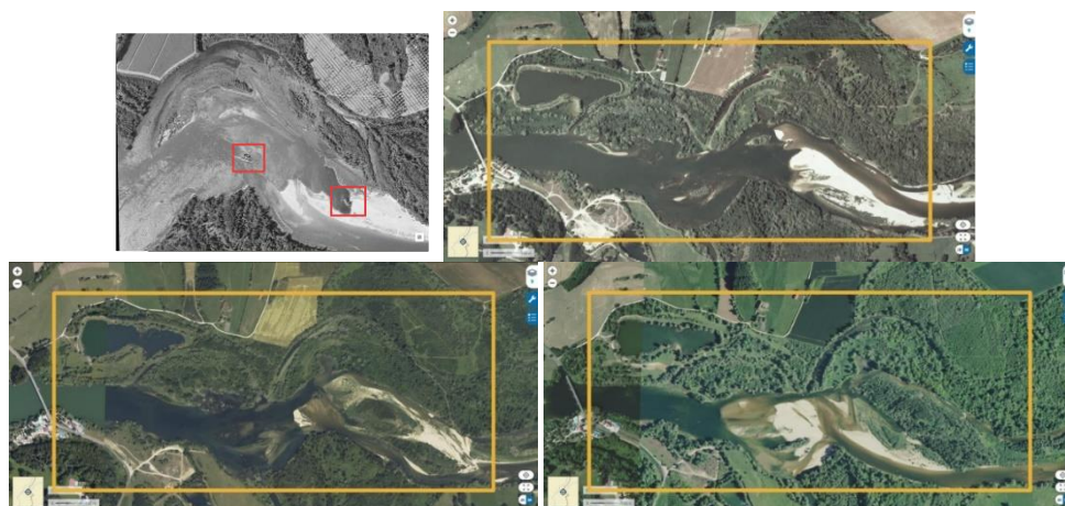
Figure 85 : exemple d'une énorme gravière réalisée dans le lit mineur du Doubs aval (39)... encore pas complètement comblée en 2020 (vue de dragues flottantes en action dans les années 70, puis situation dans les années 2000, 2010, 2020). La taille du cours d'eau (80 m de large) rend difficile une solution de type « Veyle »
