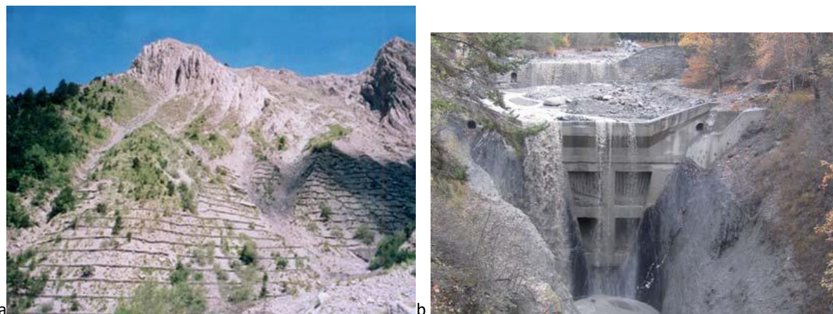
Figure 38 : quelques exemples de travaux du RTM. (a) stabilisation de versants, (b) seuils de correction torrentielle
