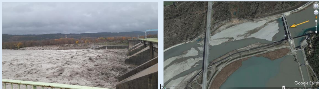
Figure 87 : a) le barrage de Cadarache en transparence. b) les bancs alluviaux liés au transit des matériaux grossiers au travers de l'ouvrage
