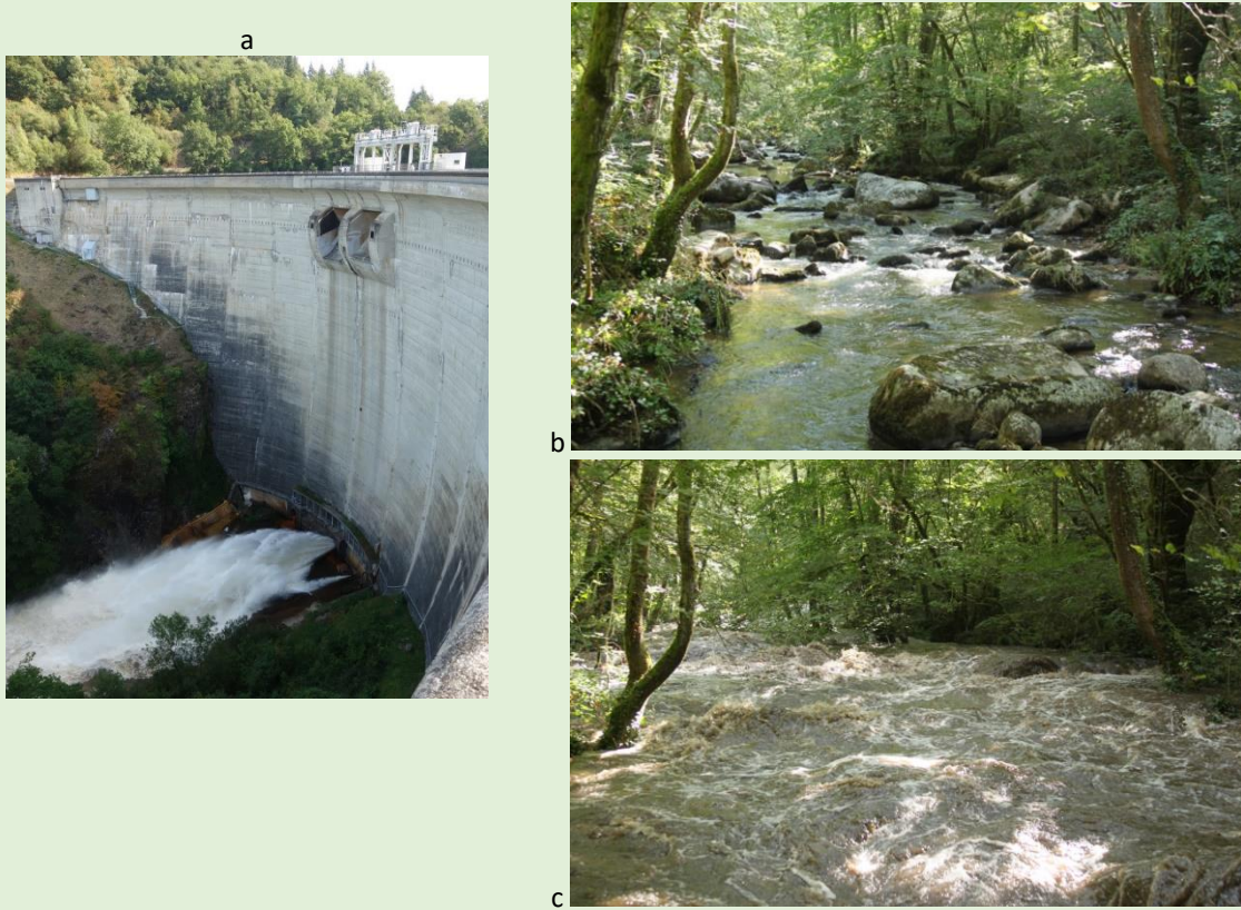
Figure 96 : a) exemple de l'un des lâchers au barrage de Maury sur la Selves et vues du cours d'eau b) au débit réservé (0.24 m³/s) et c) au moment du lâcher à 20 m³/s. © R. Loire (EDF)
