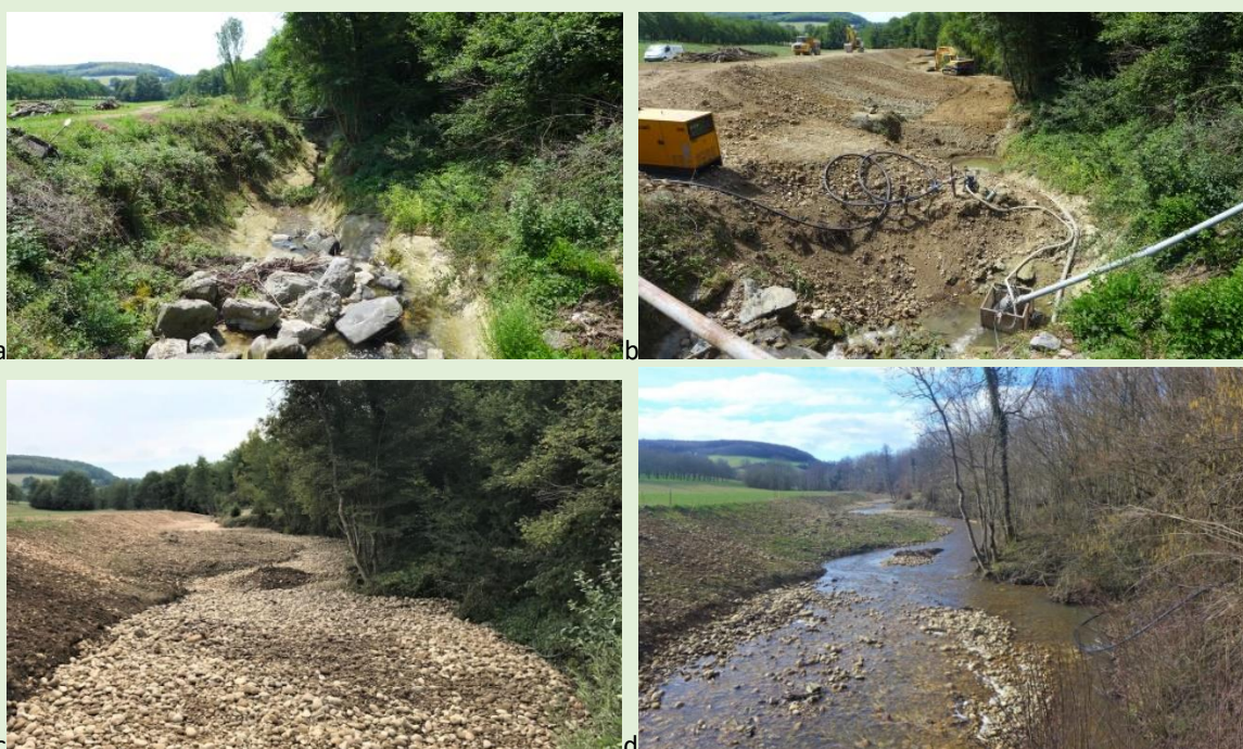
Figure 91 : les travaux de recharge alluviale sur l'Herbasse a) 06/2018, b) 07/2018, c) 09/2018 d) 03/2019. © Biotec
