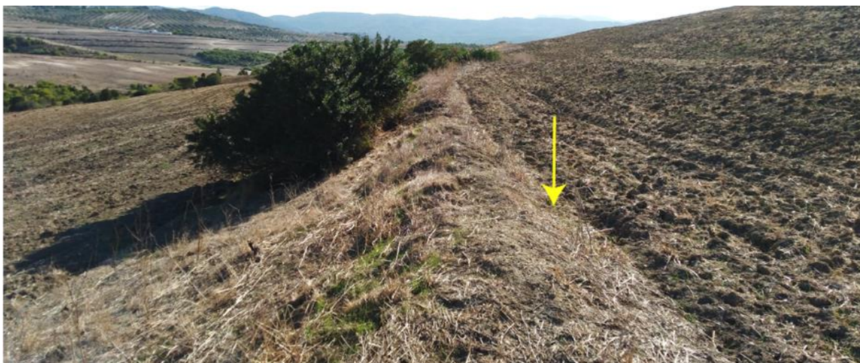
Photo 13- Exemple d'une banquette dont le canal amont a été effacé par les labours et les dépôts de sédiments (AMRI S., juin 2022)
