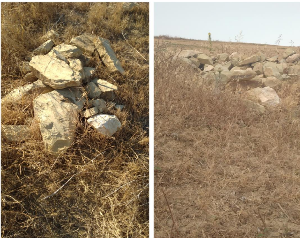
Photo 20- Corrections des brèches par des pierres sèches (AMRI S., juin 2022)
