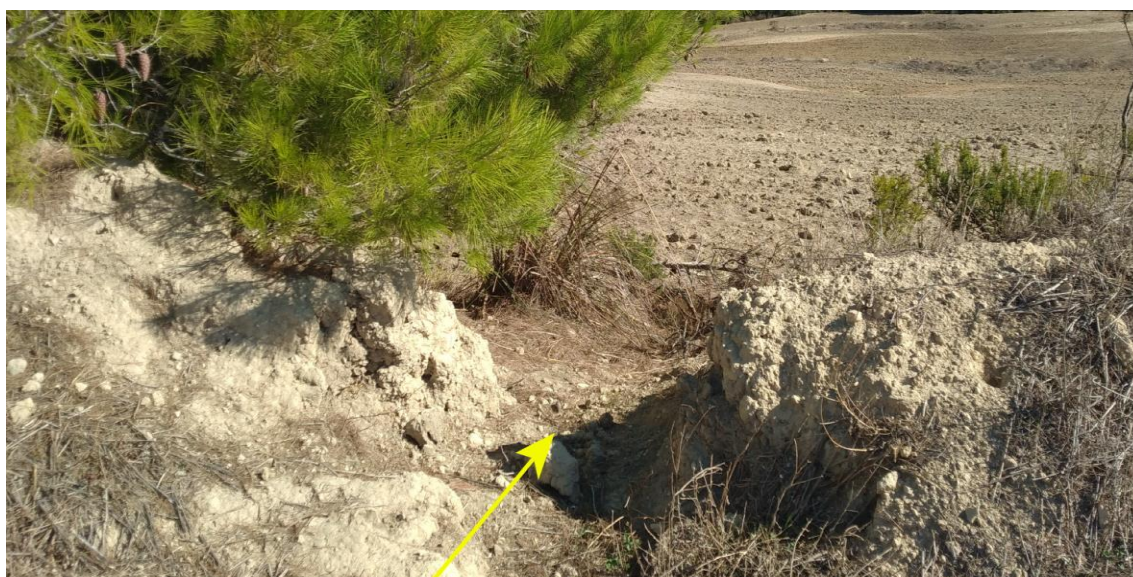
Photo 14- Rupture complète de la banquette (AMRI S., juin 2022)
