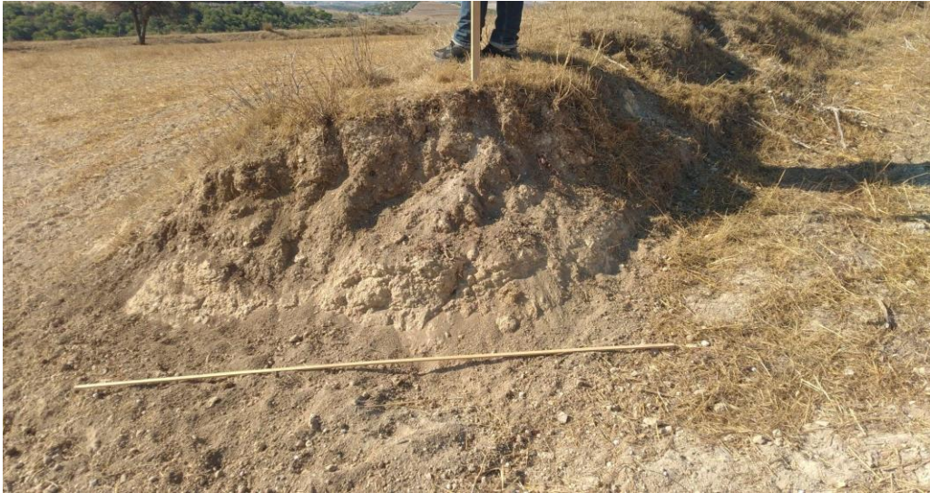
Photo 17- Dégradation des extrémités d'une banquette (AMRI S., juin 2022)
