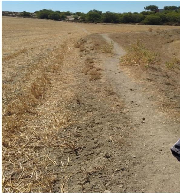
Photo 15- Affaissement longitudinal de la banquette avec création d'une dépression centrale à l'endroit du passage répété du bétail (AMRI S., juin 2022)
