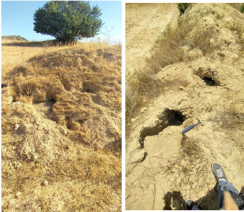
Photo 18- Banquette affectée par des galeries creusées par des rongeurs (AMRI S., juin 2022)
