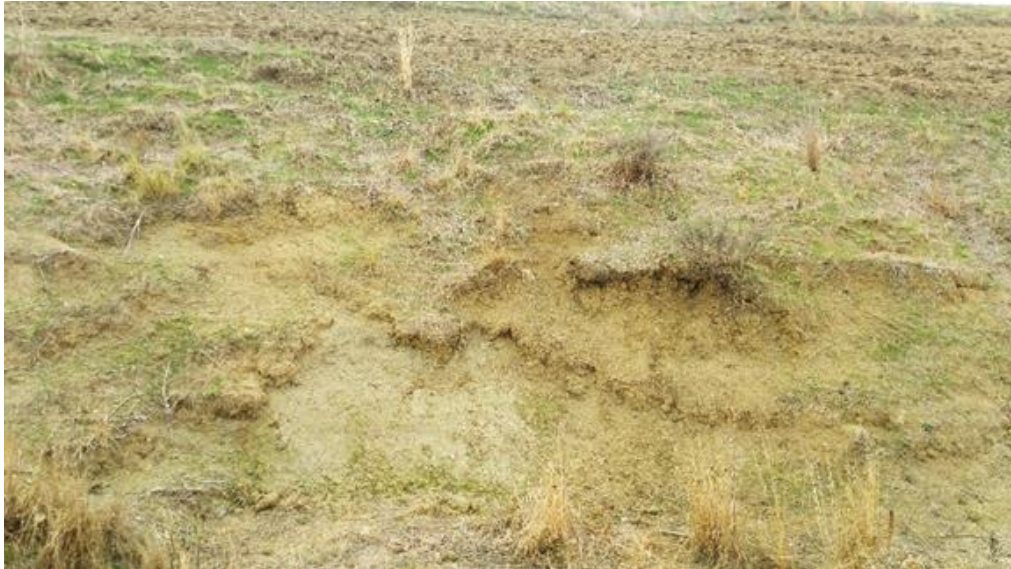
Photo 11- Glissement des berges sous forme de pans (AMRI S., juillet 2022)
