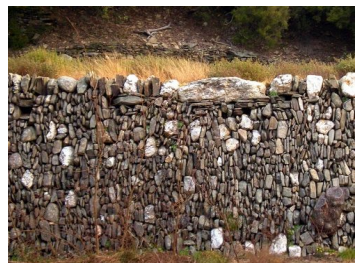
Soutènement clavé - Cévennes
