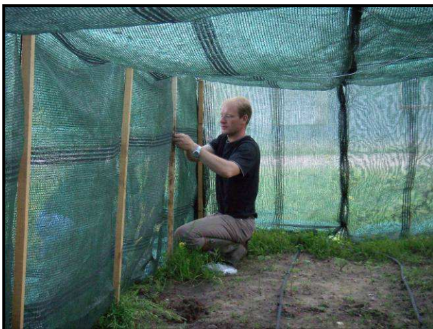
Photo 16. Phase d'installation des ombrières.
