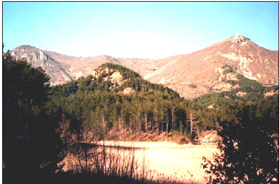
Photo 2 : Le barrage du Saignon complètement comblé
