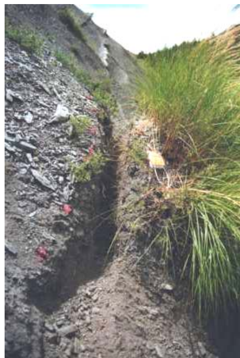
Photo 19 : Tranchée réalisée en courbe de niveau (T4)
