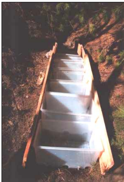
Photo 22 : Caisses en cascade constituant un piège à sédiments d'une capacité totale de 500 litres
