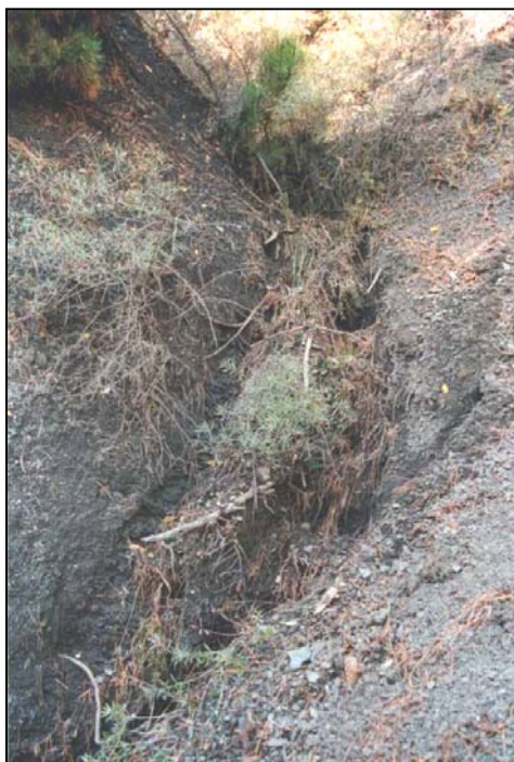
Photo 33 : Les plants de bugrane se sont comportés comme les plants de bauche : ils ont été parfois arrachés mais sont le plus souvent restés en place, couchés sous les dépôts de matériaux
