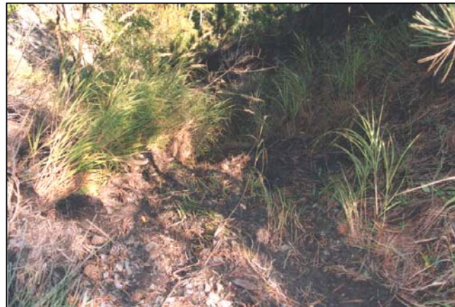
Photo 32 : Après la pluie du 20-21 Septembre 2000, la bauche semble avoir été emportée ; pourtant, elle est restée en place et s'est couchée pour laisser passer les écoulements. On la rerouve sous les sédiments déposés après l'orage
