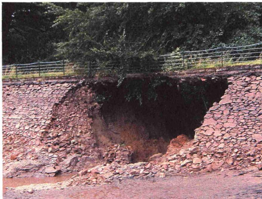
Figure 2.16 : Suffusion débouchant sur un renard hydraulique – Les Ouches (63)
