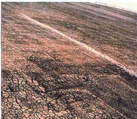
Figure 2.20 : Dégradation du masque en béton bitumineux – St Cécile d'Andorge (30)
