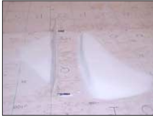
Photographie 20 : dépôt autour d'une barrière.
