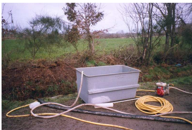
Photo B-2 : dispositif d'injection dans le fossé
