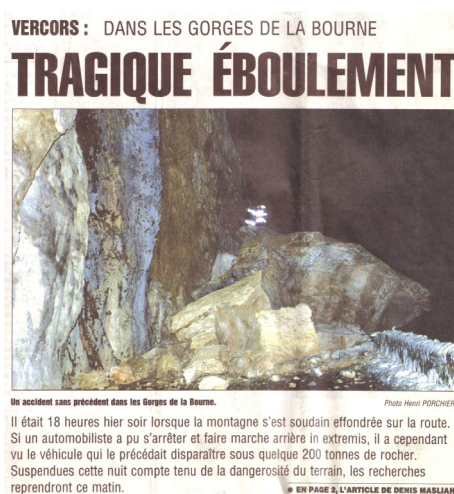
Fig. II. 12 - Éboulement sur la route des gorges de la Bourne (Dauphiné Libéré du 31/01/2004)
