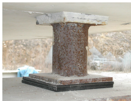
Fig. IV. 9 – Dispositions pratiques des appuis fusibles [Tonello 2001] et vue réelle
