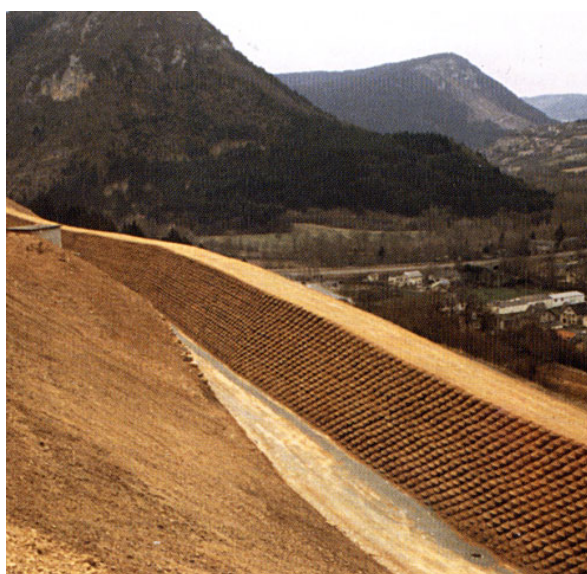
Fig. II. 19 - Protection passive pare-bloc : merlon et filets (Cemagref & CETE)
