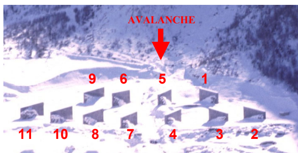
Fig. IV. 68 – Numérotation des dents déflectrices de Taconnaz
