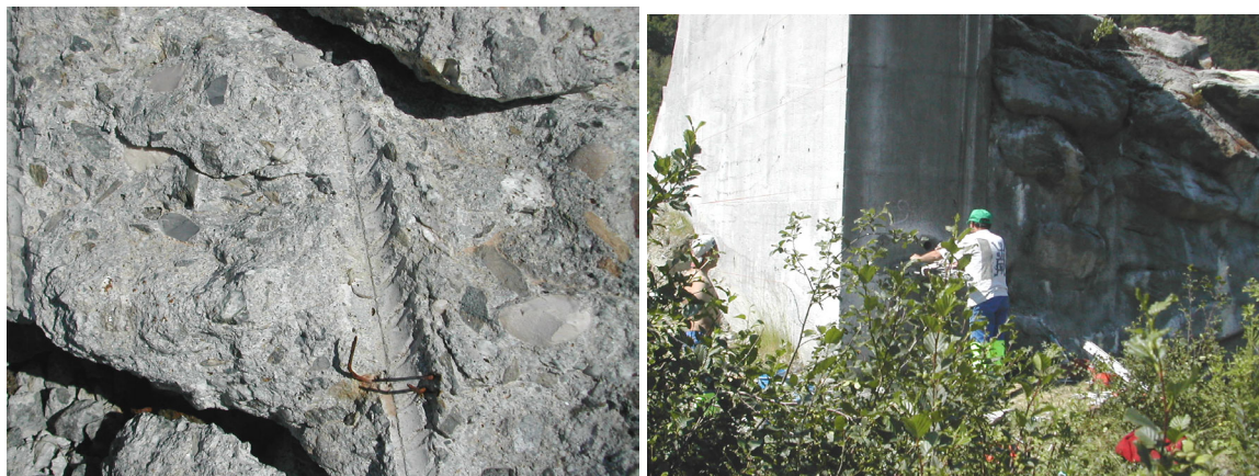
Fig. IV. 77 – Empreinte d'armature et granulats rompus dans les zones de fracture, prélèvement de béton (PBR)
