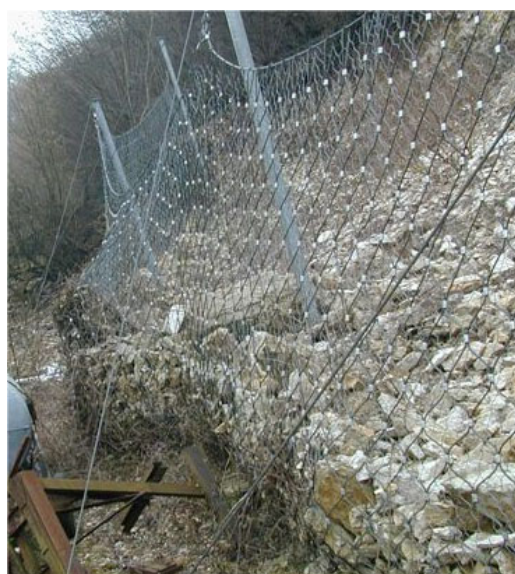
Fig. II. 19 - Protection passive pare-bloc : merlon et filets (Cemagref & CETE)
