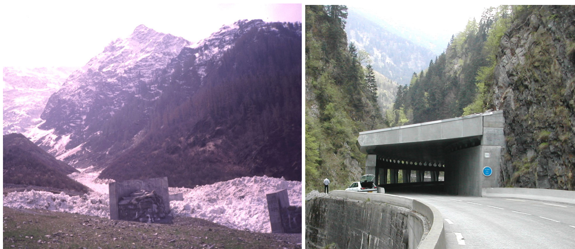
Fig. II. 21 - Ouvrages de protection en béton armé : Murs déflecteurs de Taconnaz et galerie PSD des Essariaux (Cemagref F. Rapin & PBR)
