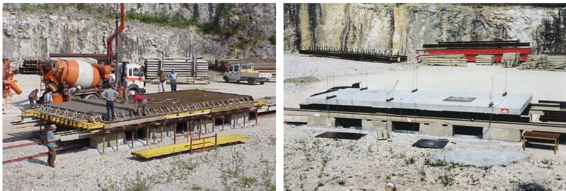
Fig. IV. 5 – Coulage du béton et maquette PSD terminée (LOCIE & Tonello IC)
