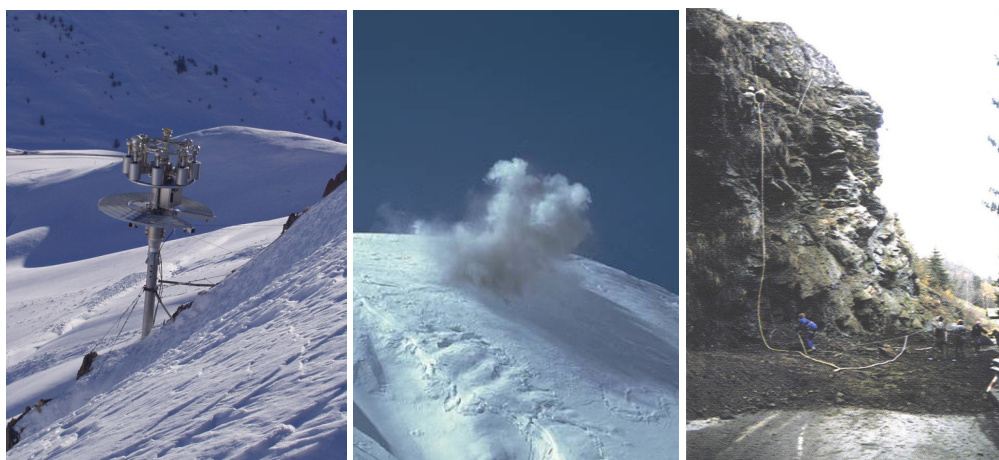
Fig. II. 15 - Défense temporaire active : Avalhex et déclenchement préventif d'avalanche, purge-déroctage (Cemagref & CETE)
