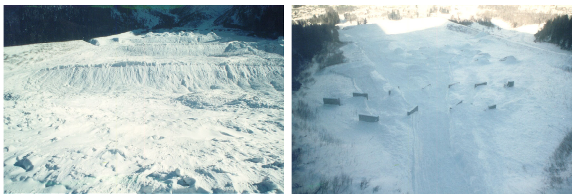
Fig. IV. 67 – Dépôt dans le dispositif depuis l'aval et l'amont (12-02-1999, F. Rapin, Cemagref)
