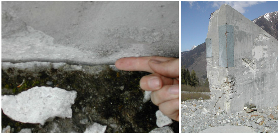
Fig. IV. 75 – Décollement entre la dent et le massif et exemple d'impacts (dent n°7) (PBR)
