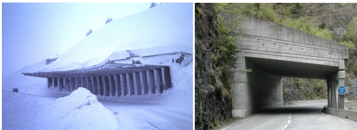
Fig. II. 20 - Galerie de protection routière paravalanche et pare-blocs (Cemagref F.Rapin & PBR)
