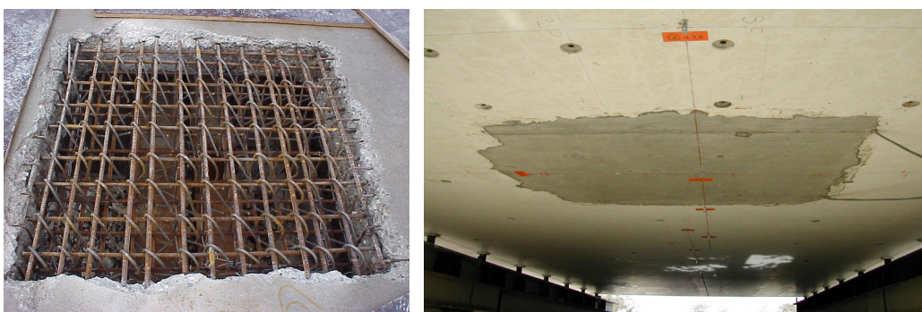
Fig. IV. 12 – Ferrailage de la zone hydro-démolie et après réparation (LOCIE & PBR)
