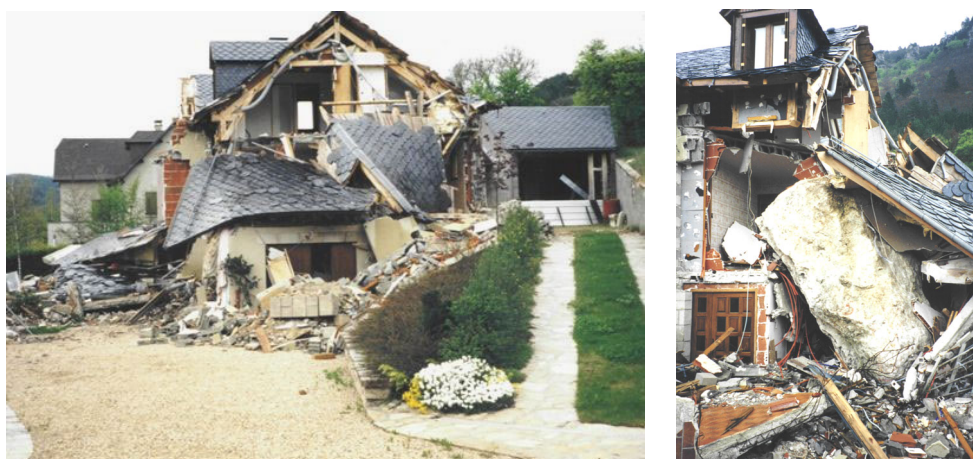
Fig. II. 13 - Chute d'un bloc sur une habitation à Barjac (Lozère) le 05/10/1995 (CETE Lyon – P. Guillemin)
