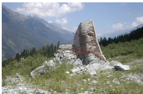
Fig. IV. 2 – Dent paravalanche défectrice de Taconnaz détruite en 1999 (PBR)
