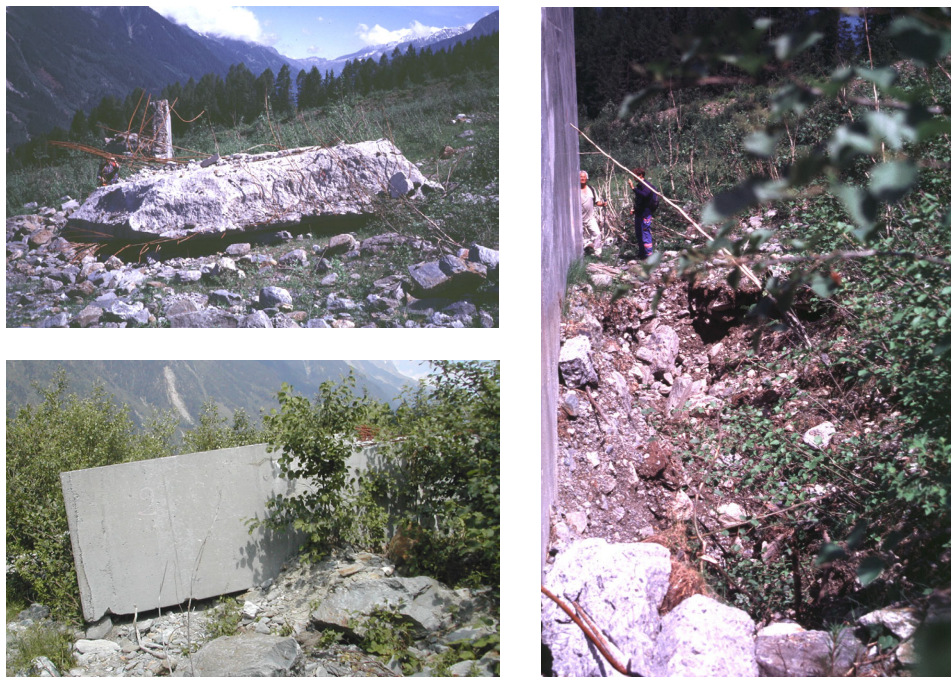
Fig. IV. 71 – Coins arrachés, des dents n°9 et n°11 (PBR) et fossé créé à l'amont par le recul de la dent n°11 (F. Rapin)
