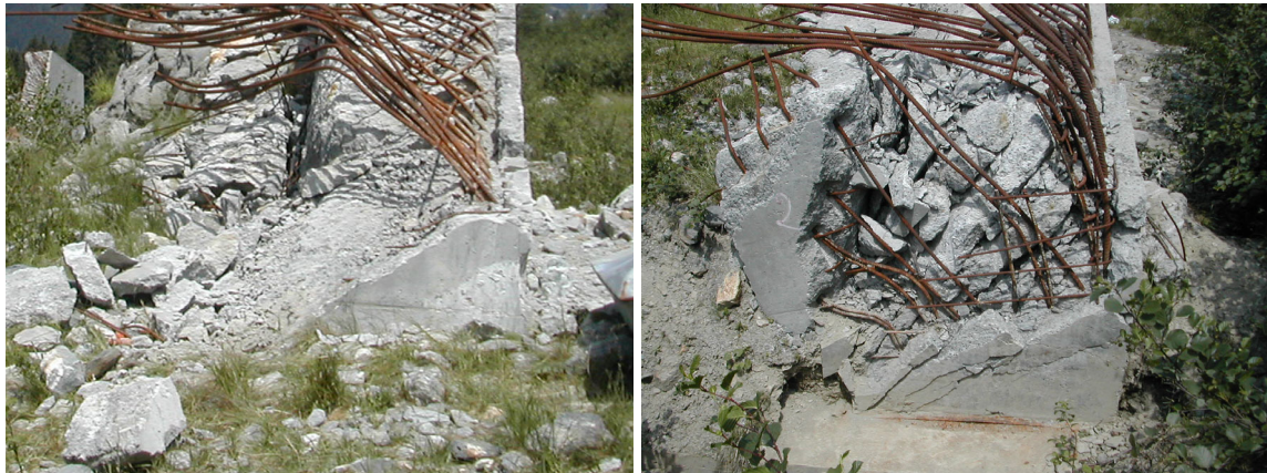
Fig. IV. 74 – Extrémité en biseau du plan de fracturation de la dent n°9 et fracture de compression pour la dent n°11 (PBR)
