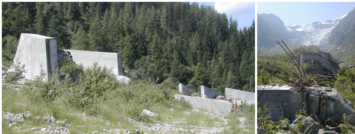
Fig. IV. 69 – Dent amont et son coin arraché, vue latérale et aval (PBR)
