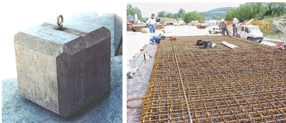
Fig. IV. 6 – Bloc en béton armé et ferrailage de la dalle (LOCIE & Tonello IC)
