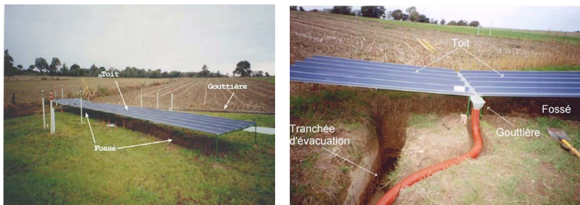
Figure II-8 : a - Toit du fossé, et b - Détail du système d'évacuation de l'eau pluviale.
