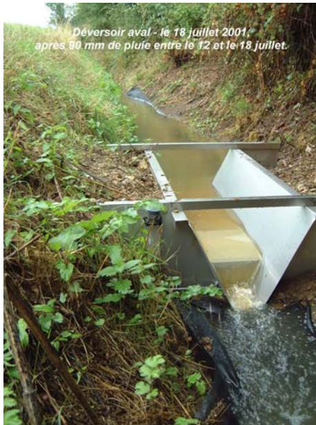
Figure II-31 : Canal jaugeur aval
