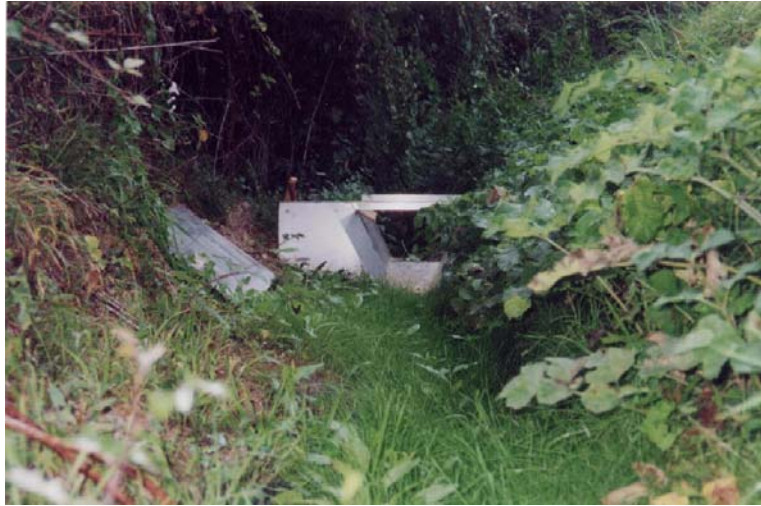
Figure II-27 : Vue du fond du fossé, fortement végétalisé.
