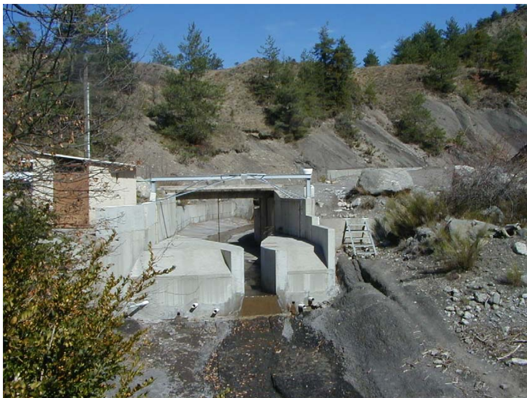
Photo 2 : Canal auto-jaugeur du bassin versant du Laval.
