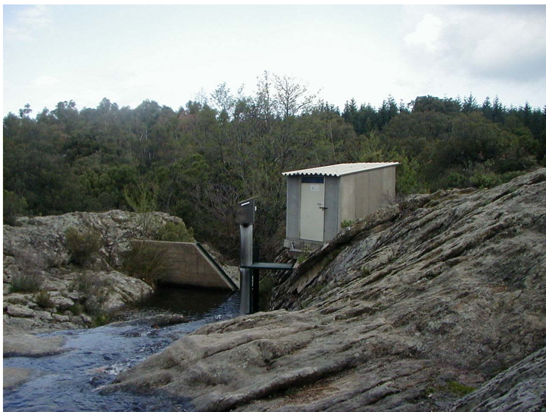
Photo 4 : Station de jaugeage du bassin versant du Rimbaud.
