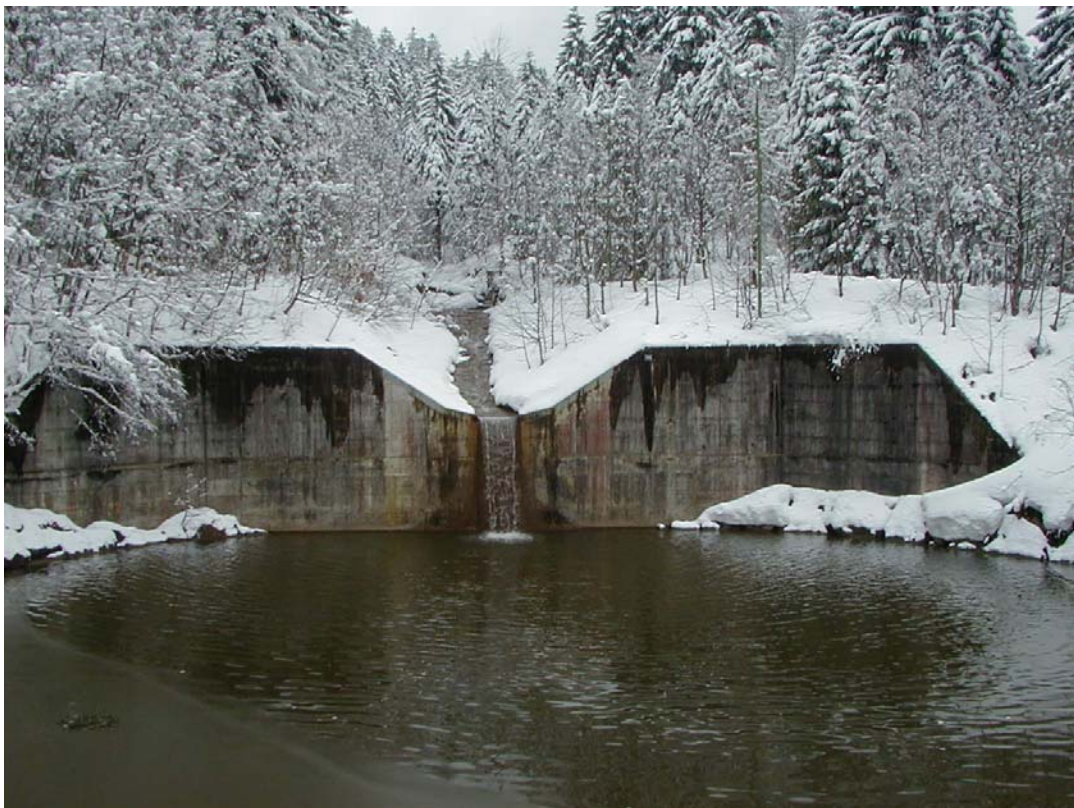
Photo 10 : Plage de dépôt du torrent de l'Erlenbach (Vallée de l'Alptal).
